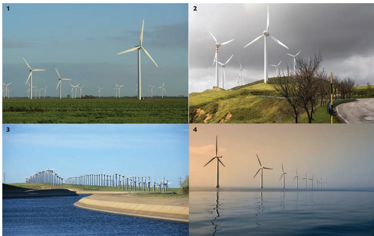
Figura 4. Plantas eololéctricas: 1. Tierra adentro en superficies planas; 2. Tierra adentro en lugares escarpados; 3. Cerca de la costa; y 4. Fuera de la costa.
